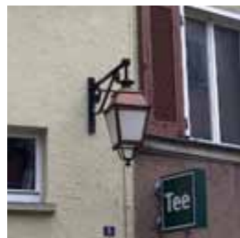
Altstadtleuchte in Tübingen, umgerüstet von HQL auf LED
