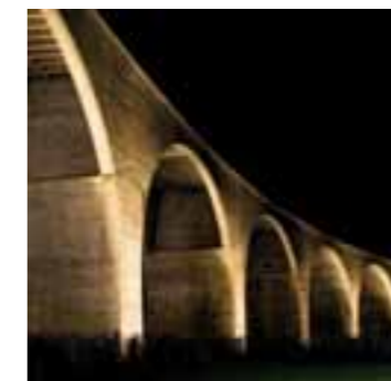
Nagoldtalviadukt, beleuchtet mit LED, 530 m lang, 23 m hoch
